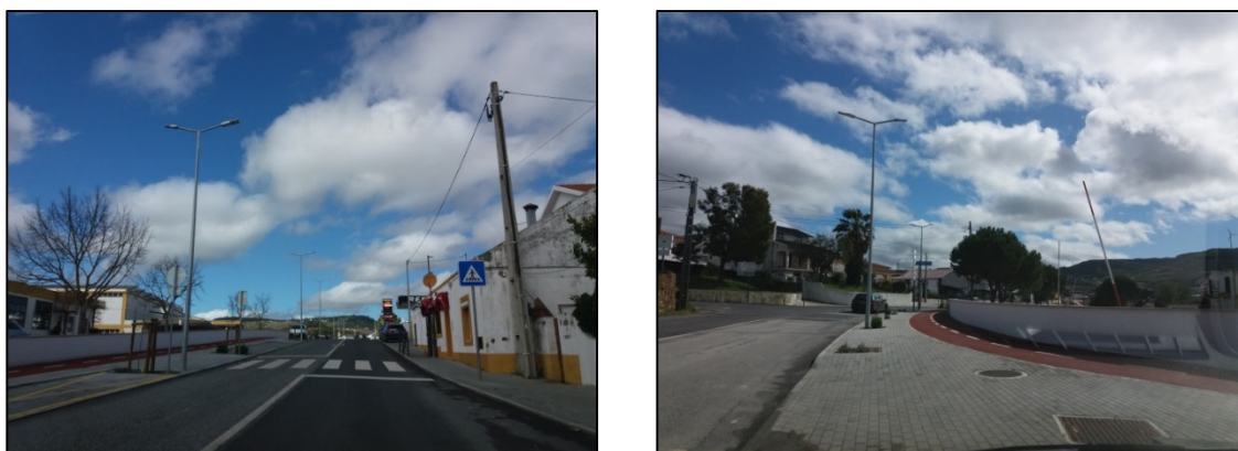
Figura 3 – Requalificação da Rua Eng.º Francisco Borges, em Arruda dos Vinhos
