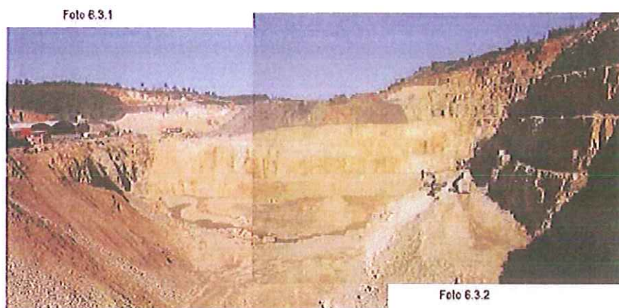
FIGURA 7 Fotografias 6.3.1 e 6.3.2 - Vista da Depressão onde será Implementado o Aterro onde Assentará a Plataforma da Fábrica de Cimento
