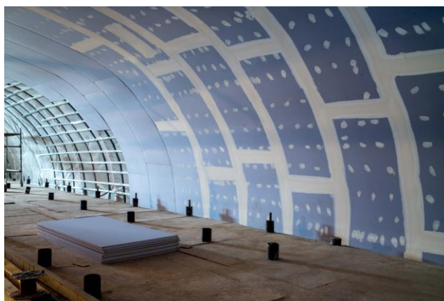
Fig. 37 – Construção de uma segunda ‘pele’ abaixo do teto para execução da pintura, 2016, Paulo Catrica.
