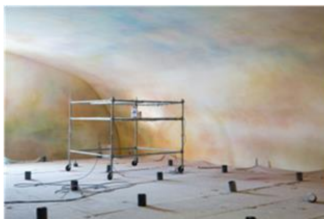
Fig. 37 – Construção de uma segunda ‘pele’ abaixo do teto para execução da pintura, 2016, Paulo Catrica.
