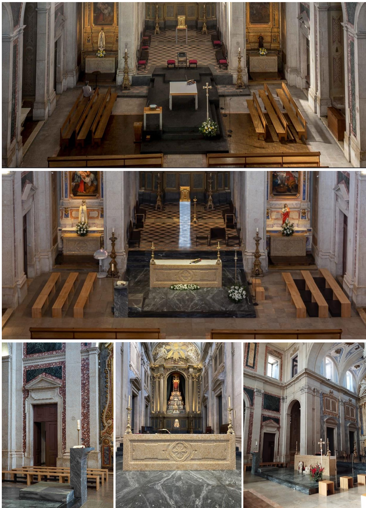
Fig. 17 – Foto superior: presbitério antes da reformulação. Fotos seguintes: o mesmo espaço após a execução de nova plataforma em ruivina, ambão pétreo, reintegração do altar-mor original e colocação de novo mobiliário litúrgico.
