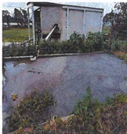
Figura 2 - Tanque para decantar algumas areias do EP proveniente do tamisador (Fonte: Foto, visita CA)
