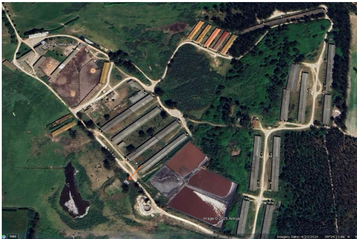
Figura 4 - Localização (estimada) da bacia de acumulação de efluente da figura 3, assinalada com seta cor-de-laranja (Fonte: Google Earth)
