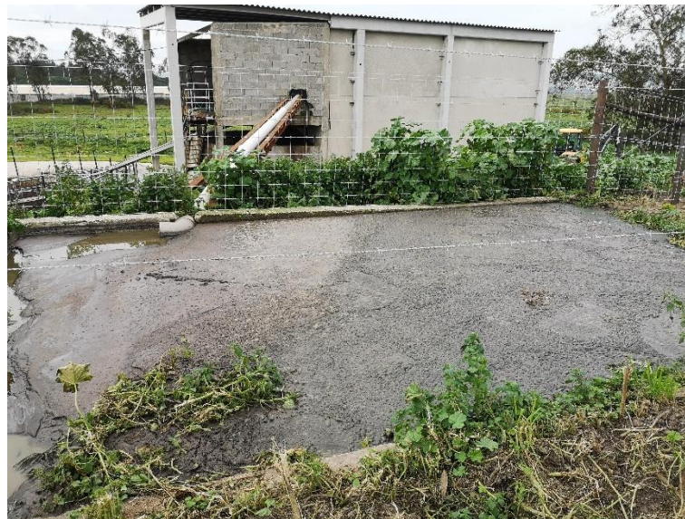
Figura 7 - Tanque para decantar algumas areias do EP proveniente do tamisador (Fonte: Foto, visita CA)
