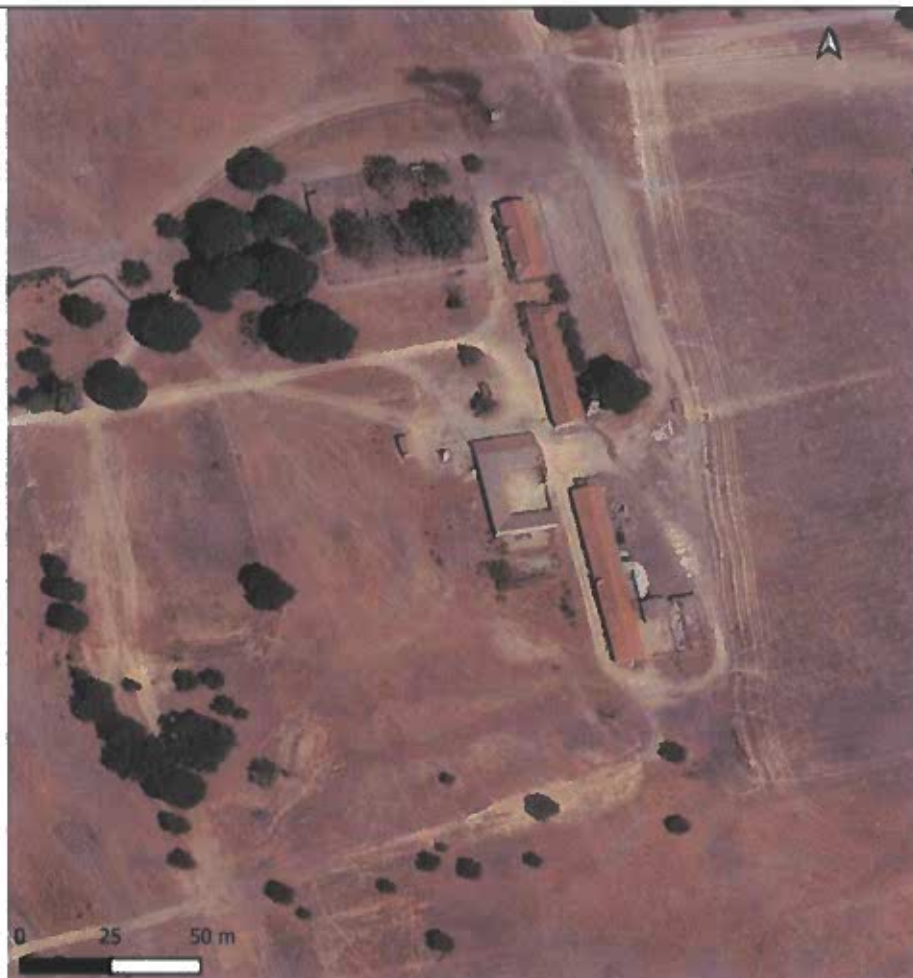
Figura 2 - Construções existentes na Quinta das Sesmarías (Fonte: EIA consolidado, dezembro 2025)
