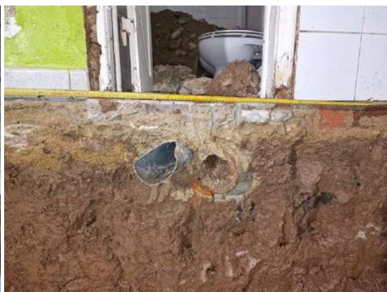
Foto 24_Vista em corte da sobreposição do tubo PVC [907] no tubo em cerâmica [905].
